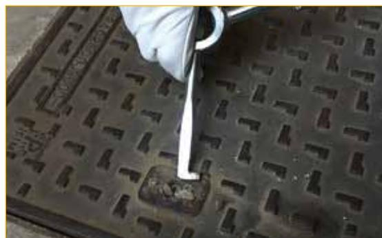
**Configurazione 2** Estremità ad "L" per raschiare nel sotto squadra delle asole e liberare la rotazione delle chiavarde.
