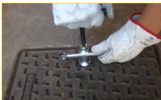
Fase 1: fissaggio della barretta centrale nella posizione favorevole alla leva.
