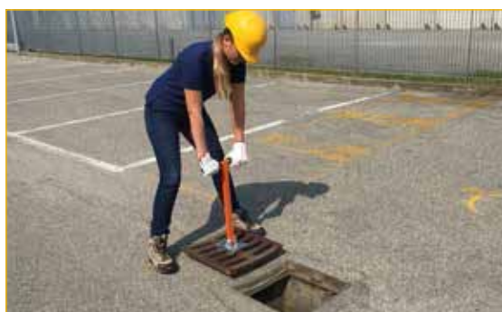
Sollevamento manuale di coperchi metallici medio/leggeri.
