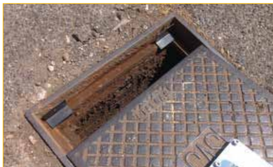
Posizionamento degli spessori tra coperchio e cornice.
