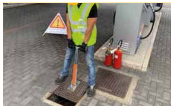
Utensili di categoria 3 ATEX adatti ad essere utilizzati in luoghi classificati ZONA 2.
