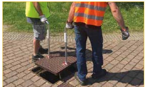
Utilizzo con due operatori in parallelo a utensile separato.
